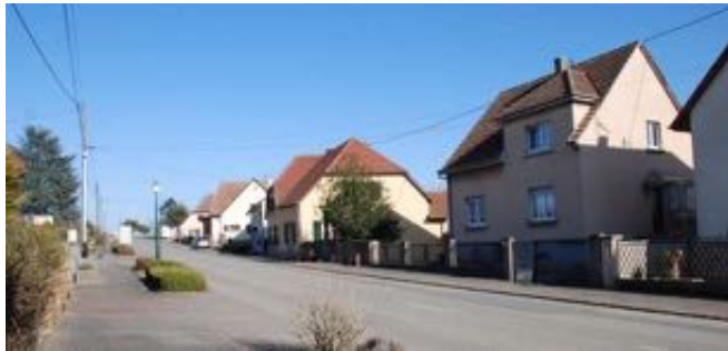
Linéaire bâti - rue du MI Leclerc - sortie nord
